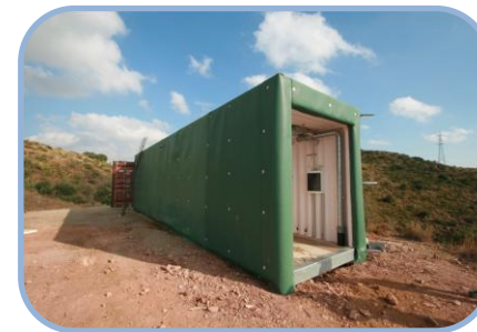
Inicio de acondicionamiento y aislamiento
